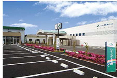
南ホール外観
