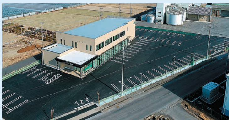
▲新事務所 全体
